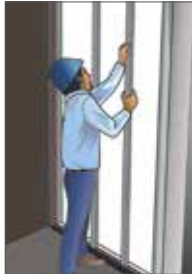
Step 02 Framing (Studs)
